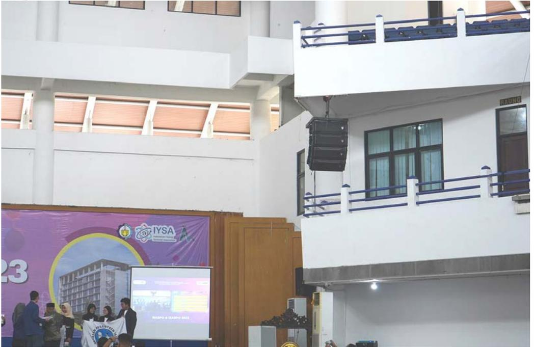
Pemasangannya dilakukan di salah satu sudut gedung (seperti di gambar) cukup sederhana dan mudah. Kombinasi speaker dan subwoofer ini dirasa sangat cukup mengakomodir suara secara merata hingga seluruh area pendengar di segala sisi.
